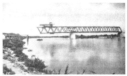
A fő nyílás 2x103,25 m támaszközű. A főtartó folytonos három támaszú rácsos tartó, csupán ferde rácsrudakkal, a függőleges rácsrudak hiányoznak. Ez az elrendezés a vasmegtakarításon kívül levegős képet mutat. Elhagyták a felső övek közt szokásos keresztkötéseket is.
